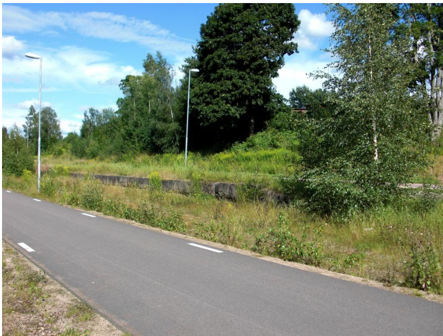
Lämningar efter perrongen längs landsvägen.
