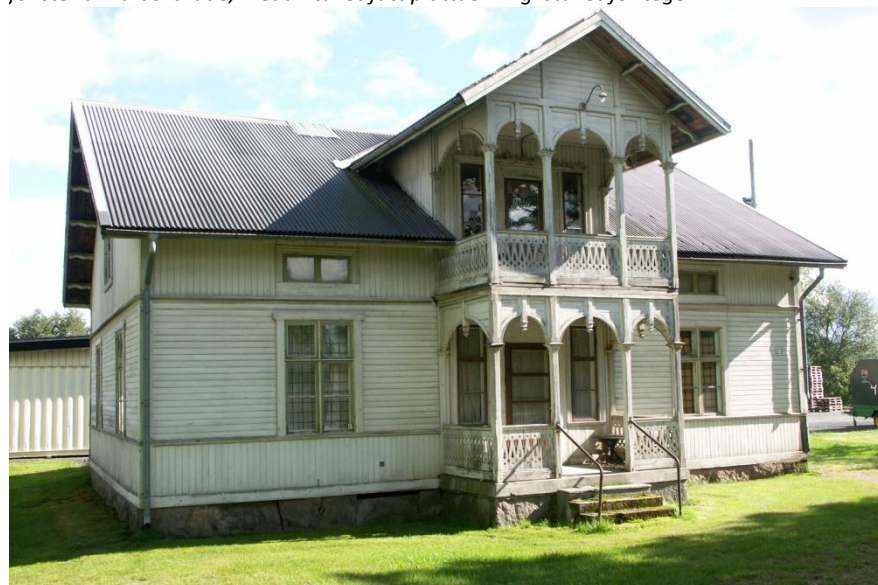
Munkerudsvägen 23A. En av de exteriört välbevarade villorna från sekelskiftet. Panel och fönster är välbevarade om än i visst behov av underhåll. Taket har fått plåttäckning istället för tegel.
