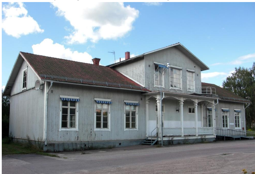
Bruksgatan 29. Har tidigare fungerat som servering.
