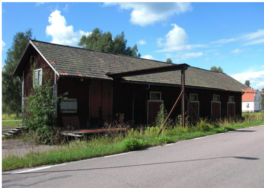
Magasinsbyggnaden, östra fasaden.
