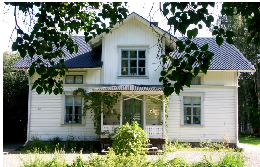
Munkerudsvägen 47. En av de exteriört välbevarade villorna från sekelskiftet. Panel och fönster är välbevarade, medan taket fått plåttäckning istället för tegel.
