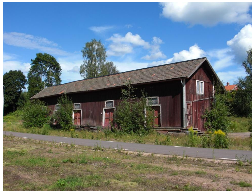
Magasinsbyggnaden, västra fasaden.
